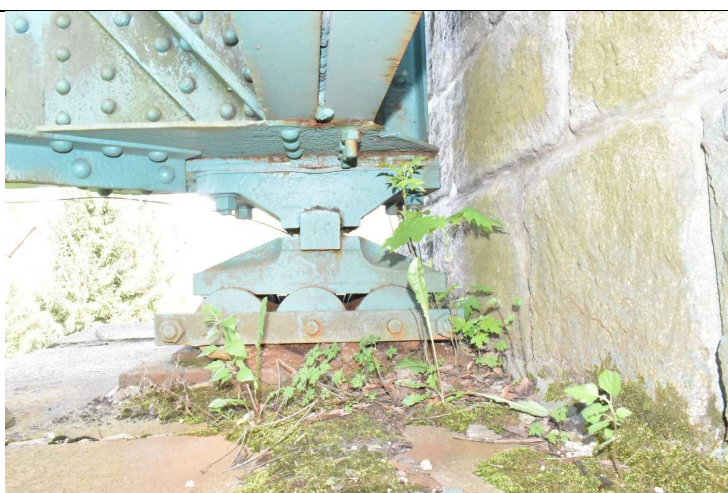
Obrázek 3. K 02 pohyblivé ložisko na P 01 vpravo –
